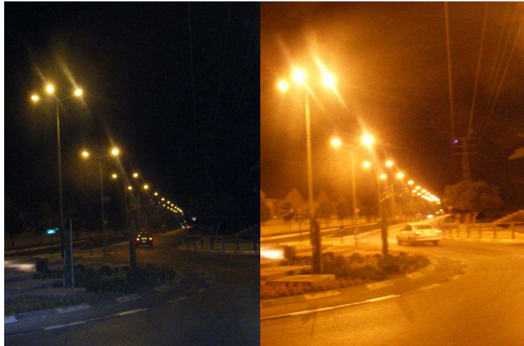
החלפת משנקים אלקטרומגנטיים של תאורת רחוב בבאר שבע (בתמונה משמאל) למשנקים אלקטרוניים יעילים (בתמונה מימין) – תאורה בהירה יותר, חסכונית יותר, שהביאה לחסכון כספי ניכר. התמונה באדיבות מטרולייט.
